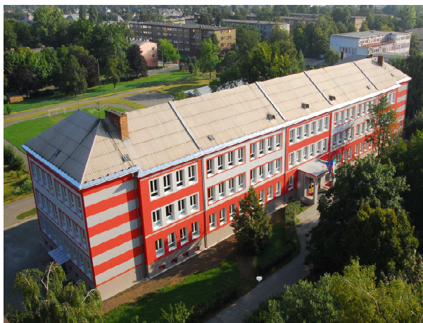
Základní škola Ostrava – Hrabůvka
